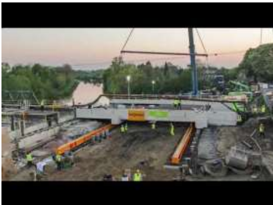
Eind april 2019 - Lingense Alliantie aan het werk bij de brug over de Linge en aan de tunnel voor voetganger en fietser
