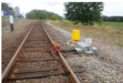
Foto links: Het stopontspoorblok is geactiveerd op het spoor naar de zinkfabriek. Foto rechts: Waarschuwbordjes o.a. bij de onbewaakte overweg in de weg Heuvel
